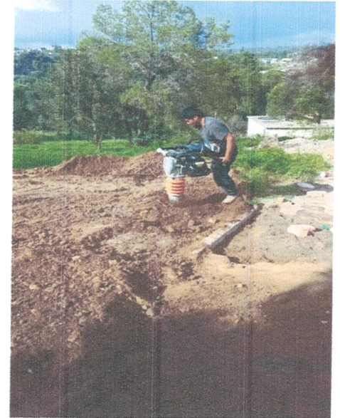
A-06 RELLENO COMPACTADO CON MEDIOS MECANICOS EN CEPAS DE 20CM, UTILIZANDO MATERIAL PRODUCTO DE LA EXCAVACION, INCLUYE: MATERIAL, MANO DE OBRA, HERRAMIENTA, EQUIPO Y TODO LO NECESARIO PARA SU CORRECTA EJECUCION.
