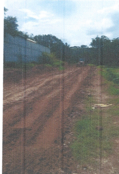
A-06 RELLENO COMPACTADO CON MEDIOS MECANICOS EN CEPAS DE 20CM, UTILIZANDO MATERIAL PRODUCTO DE LA EXCAVACION, INCLUYE: MATERIAL, MANO DE OBRA, HERRAMIENTA, EQUIPO Y TODO LO NECESARIO PARA SU CORRECTA EJECUCION.
