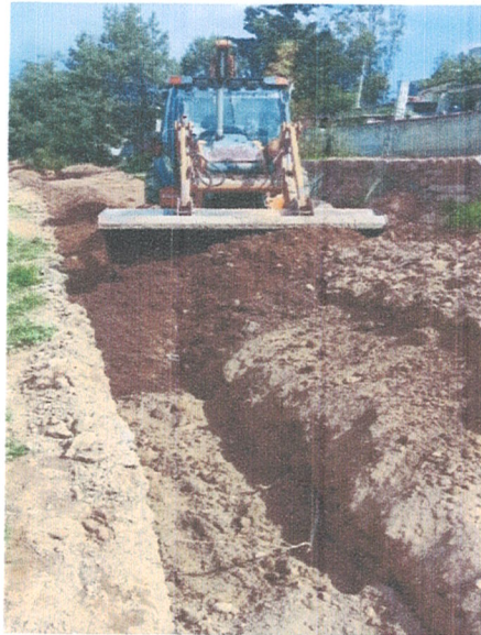
A-06 RELLENO COMPACTADO CON MEDIOS MECANICOS EN CEPAS DE 20CM, UTILIZANDO MATERIAL PRODUCTO DE LA EXCAVACION, INCLUYE: MATERIAL, MANO DE OBRA, HERRAMIENTA, EQUIPO Y TODO LO NECESARIO PARA SU CORRECTA EJECUCION.
