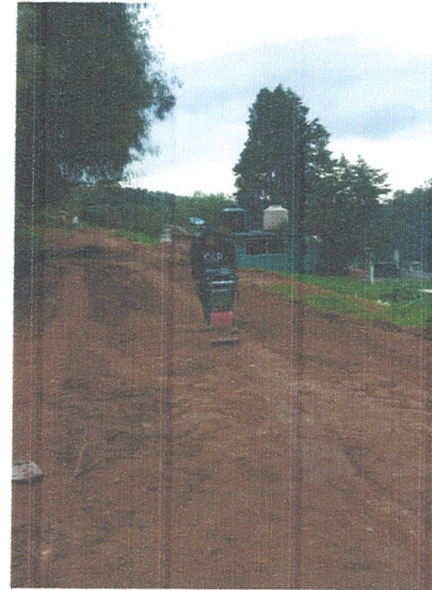
A-06 RELLENO COMPACTADO CON MEDIOS MECANICOS EN CEPAS DE 20CM, UTILIZANDO MATERIAL PRODUCTO DE LA EXCAVACION, INCLUYE: MATERIAL, MANO DE OBRA, HERRAMIENTA, EQUIPO Y TODO LO NECESARIO PARA SU CORRECTA EJECUCION.
