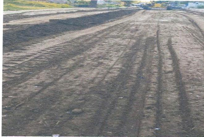
BASE HIDRAULICA CON MATERIAL DE BANCO TRITURADO DE 3/4" A FINOS COMPACTADA AL 95% DE P.V.S.M. (NO TEZONTLE) COMPRENDIDO ENTRE 1700 A 1900 KG/M3, INCORPORACIÓN DE AGUA PARA SU COMPACTACIÓN Y PRUEBAS DE LABORATORIO, INCLUYE: MATERIALES, MANO DE OBRA, HERRAMIENTA Y EQUIPO.
