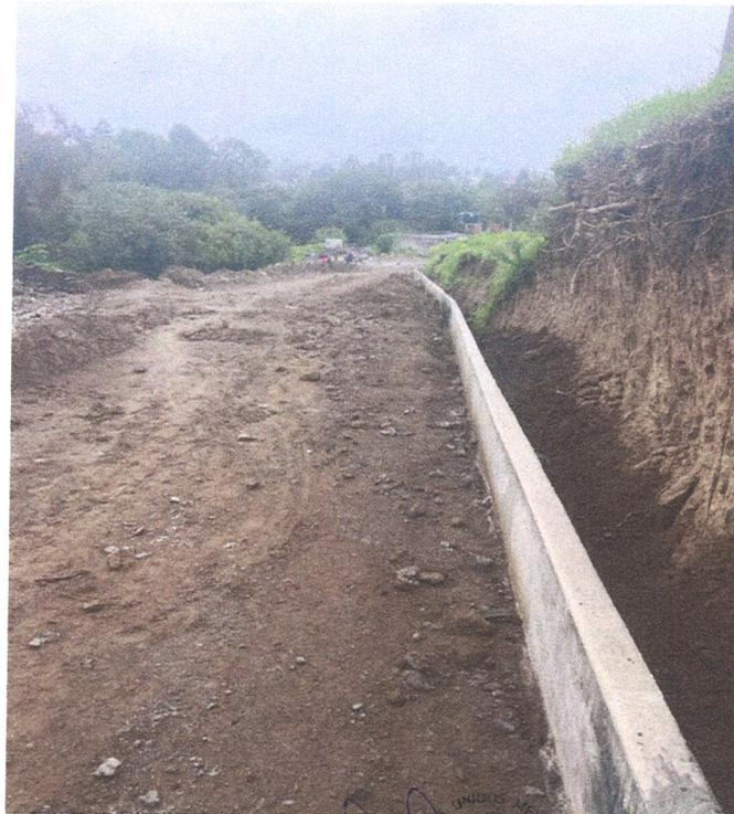
GUARNICIONES DE SECCIÓN 0.12X0.20X0.50 MTS. DE CONCRETO HECHO EN OBRA CON REVOLVEDORA DE UN SACO, RESISTENCIA NORMAL F'c= 150 KG/CM2, VACIADO CON CARRETILLA Y BOTES, REVENIMIENTO DE 10 CM, AGREGADO MAXIMO 3/4", INCLUYE: COLADO, VIBRADO Y CURADO, ACABADO APARENTE PULIDO EN CORONA CON VOLTEADOR, JUNTA CONSTRUCTIVA A 45º, MATERIALES, EQUIPO DE SEGURIDAD PARA MANO DE OBRA, LIMPIEZA, HERRAMIENTA, EQUIPO Y MANO DE OBRA, P.U.D.T.
