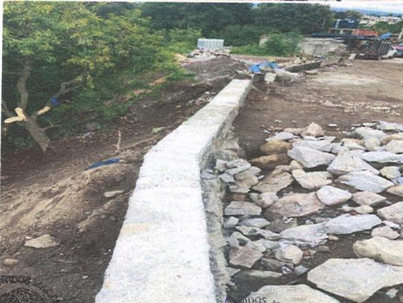
CONSTRUCCION DE MURO DE MAMPOSTERIA A BASE DE PIEDRA BRAZA, JUNTEADO CON MORTERO CEMENTO ARENA EN PROPORCION 1:5 INCLUYE: MANO DE OBRA; ACARREO LIBRE, TRAZO, NIVELACIÓN, ELEVACIONES, ACABADOS, LIMPIEZA, ANDAMIGOS, HERRAMIENTA Y MATERIALES.
