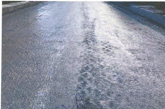
COMPACTACIÓN DE LA SUPERFICIE DESCUBIERTA DEL TERRENO NATURAL POR MEDIOS MECÁNICOS, INCORPORACIÓN DE AGUA PARA SU COMPACTACIÓN, INCLUYE: MATERIALES, MANO DE OBRA, HERRAMIENTA Y EQUIPO P.U.O.T.
