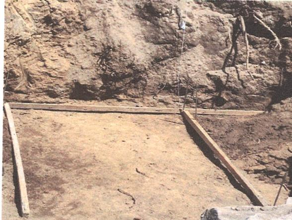
CONSTRUCCION DE PLANTILLA DE CONCRETO DE 6 CM DE ESPESOR DE UN F'c=100 KG/CM2, INCLUYE: MATERIAL, MANO DE OBRA Y HERRAMIENTA.
