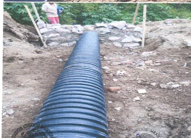
RELLENO COMPACTADO CON PRODUCTO DE EXCAVACION EN CAPAS DE 20 CMS DE ESPESOR COMPACTADO, INCLUYE: MANO DE OBRA PARA LA PREPARACION DE LA SUPERFICIE, TENDIDO, NIVELADO, INCORPORACION DE AGUA, COMPACTACION, HERRAMIENTA Y EQUIPOS NECESARIOS
