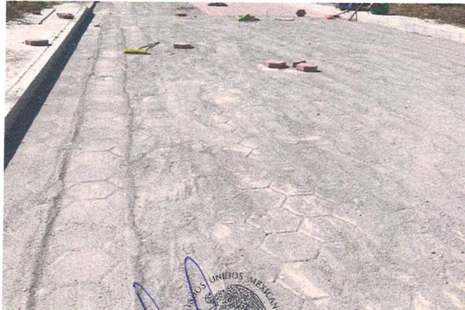
PAVIMENTO DE ADOCRETO HEXAGONAL DE 8 CM DE ESPESOR MARCA ITISA O SIMILAR CON UNA RESISTENCIA DE F'C= 280 KG/CM2, ASENTADO SOBRE CAMA DE ARENA DE 6 CM, CORTES, DESPERDICIOS, APLICACIÓN DE ARENA CRIBADA PARA EL RELLENO DE LAS JUNTAS ENTRE LOS ADOCRETOS, BARRIDO DE LOS EXCEDENTES DE ARENA, MANIOBRAS LOCALES Y PRUEBAS DE LABORATORIO, INCLUYE: MATERIALES, MANO DE OBRA, P.U.O.
